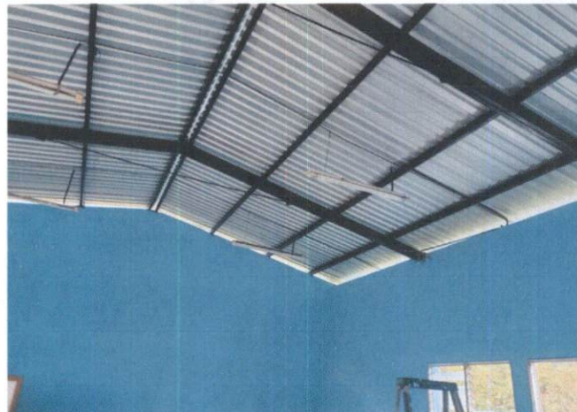
Foto 2: Mejoramiento de estructura de techo y cubierta de lámina troquelada calibre NO.26
